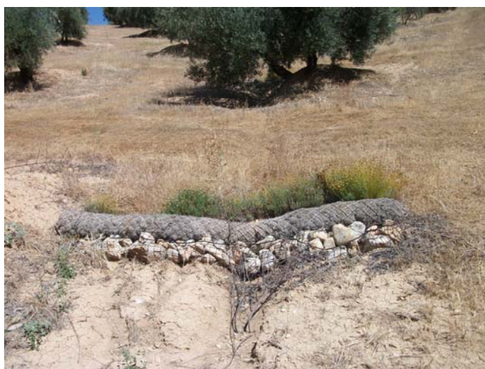
Imagen 2. Ejemplo del desarrollo de la cubierta vegetal y la disminución de la erosión del suelo en torno a los biorrollos.
