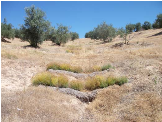
Imagen 1. Tecnología biorrollo + gavión de piedra + plantas nitrófilas bien implantada.
