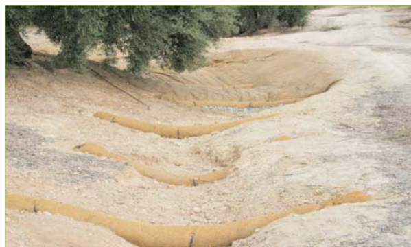
Aplicación inicial de los biorrollos en una cárcava.
